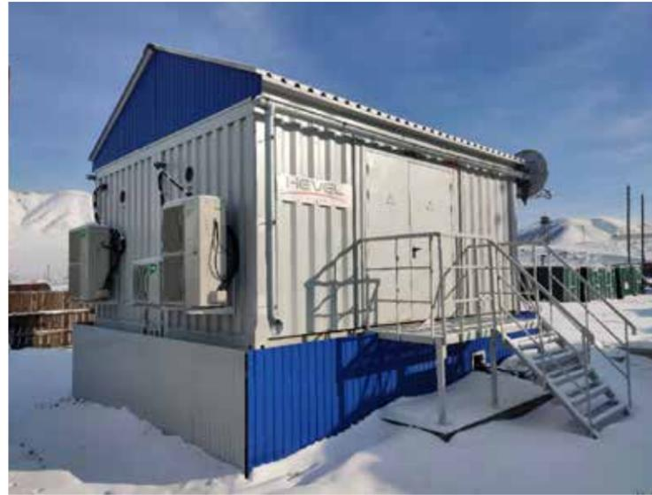
Рис. 1. СНЭ мощностью 400 кВА энергоёмкостью 460 кВт·ч в посёлке Мугур-Аксы
