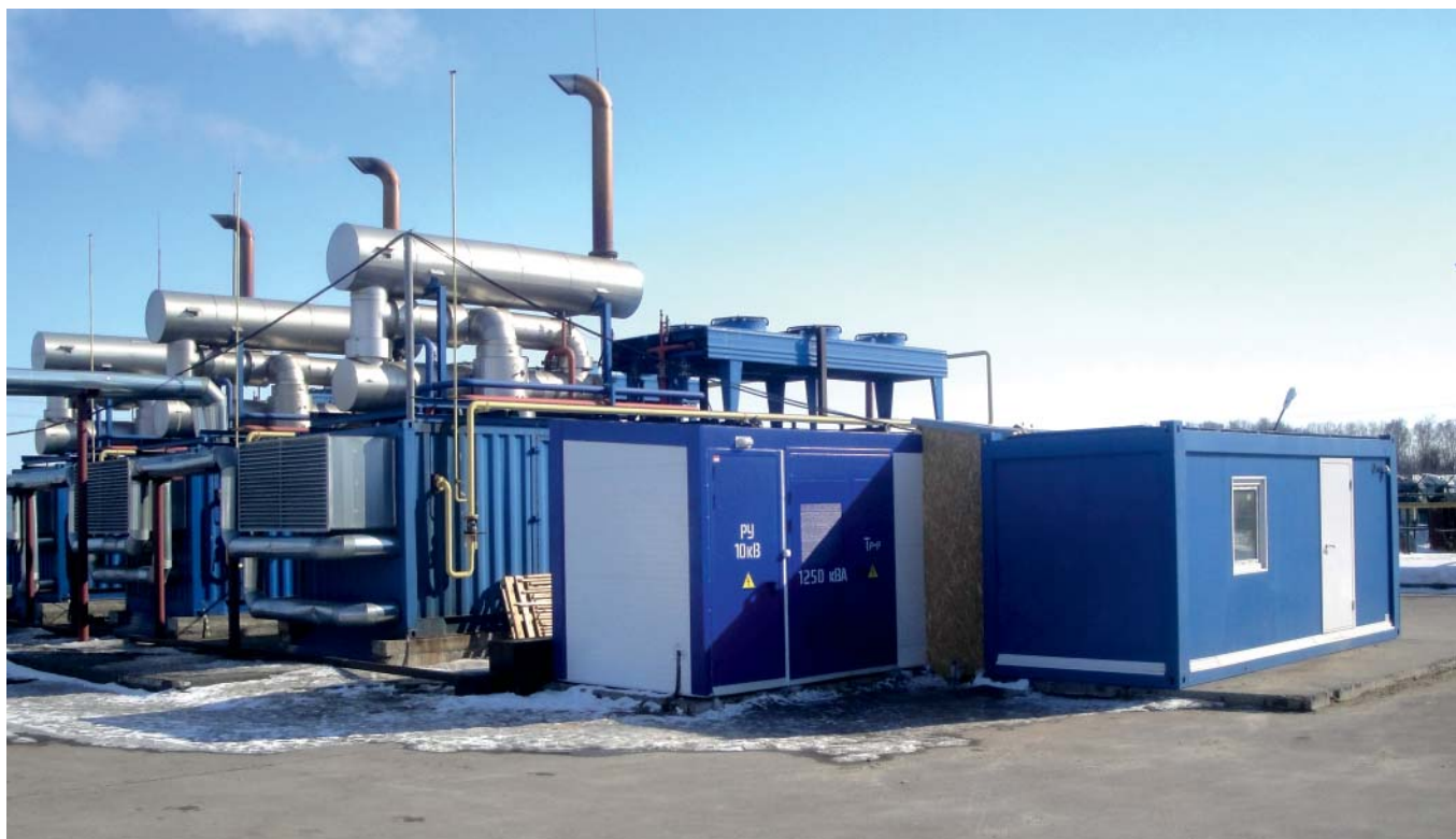
Рис. 1. Экспериментальная установка для испытаний совместной работы СНЭ-10-1200-400 и ГПУ
