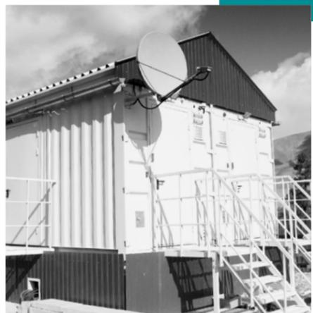
**Система хранения электрической энергии напряжением 0,4 кВ, мощностью 4 МВт\*ч, энергоёмкостью 8 МВт\*ч** в комплектных блочно - модульных зданиях для работы с солнечной электрической станцией.
